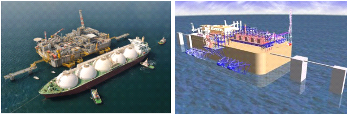
Figure 142: Adriatic LNG Terminal (94)
